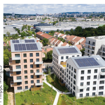
Architecte : Atelier Pascal Gontier © Philippe Monges
