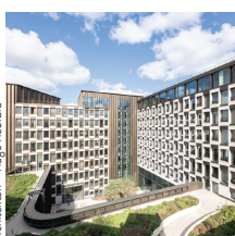
Ccaad / Baumstschlager Eberle Architekten © Hugo Hébrard
