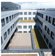
Architecte : Cabinet Brunet Saunier © Stéphanie Moreau
