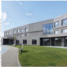
G.O. Architectes - Pandéaone Parmentier Architectes © Jonathan Alexandre
