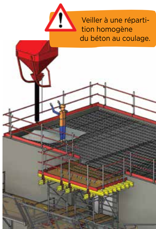
Fig. 14 • Coulage du béton.
