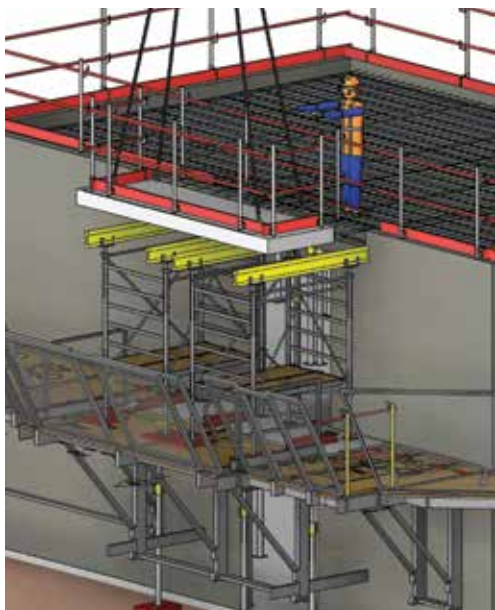
Fig. 18 • Pose du balcon (avec garde-corps intégrés).
